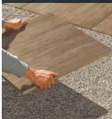
Posa ghiaia o sabbia
